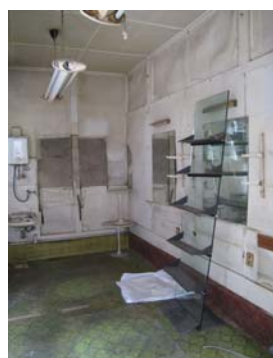
20年空き家だった木造住宅（元床屋）
